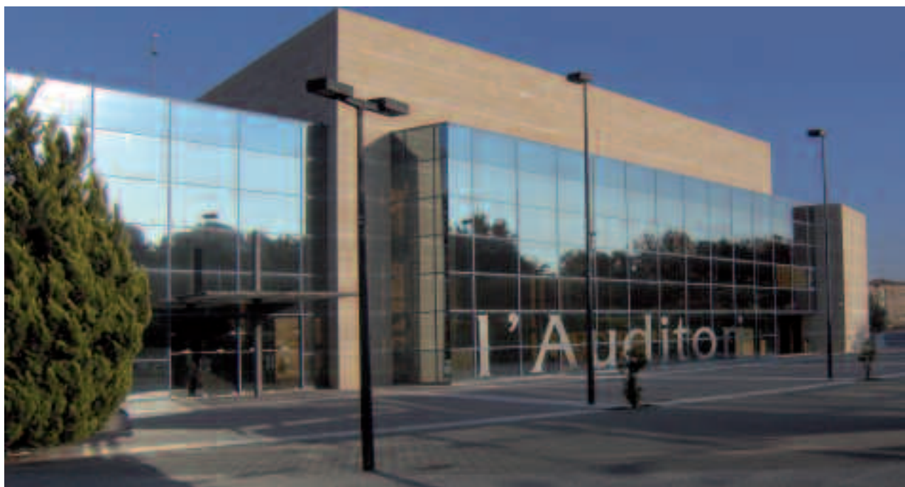
Fachada del Auditorio de Torrent
